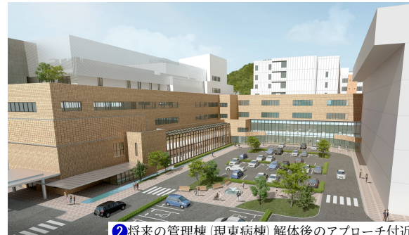
② 将来の管理棟（現東病棟）解体後のアプローチ付近
