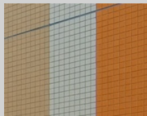
タイルを利用した外装（既存中・西病棟）
