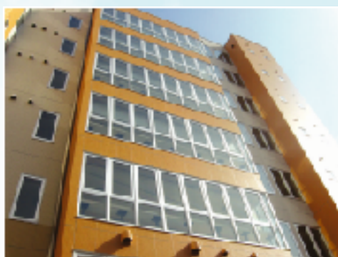
一部にオレンジ色を配色した あたたかみのある外壁
